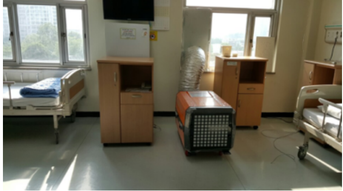
이동형 음압장비 설치
